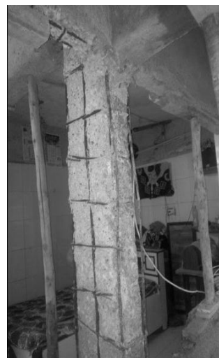
۱- شکل (اوسپنیز کانکریټي تخریب شوی
