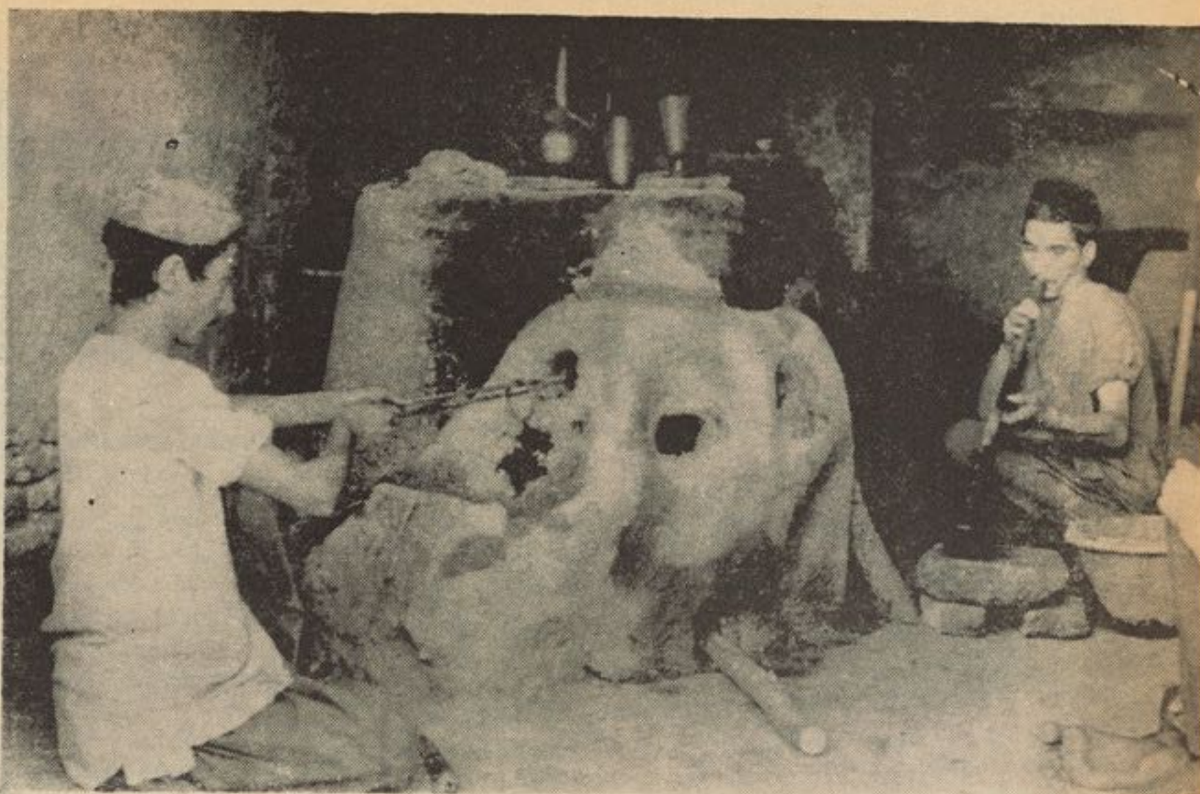
نمایی از کوره شیشه‌سازی در ولایت هرات از میان این کوره و از زیردستان این صنعت‌گران است که وسایل شیشه‌ی بی بیرون می‌آید
