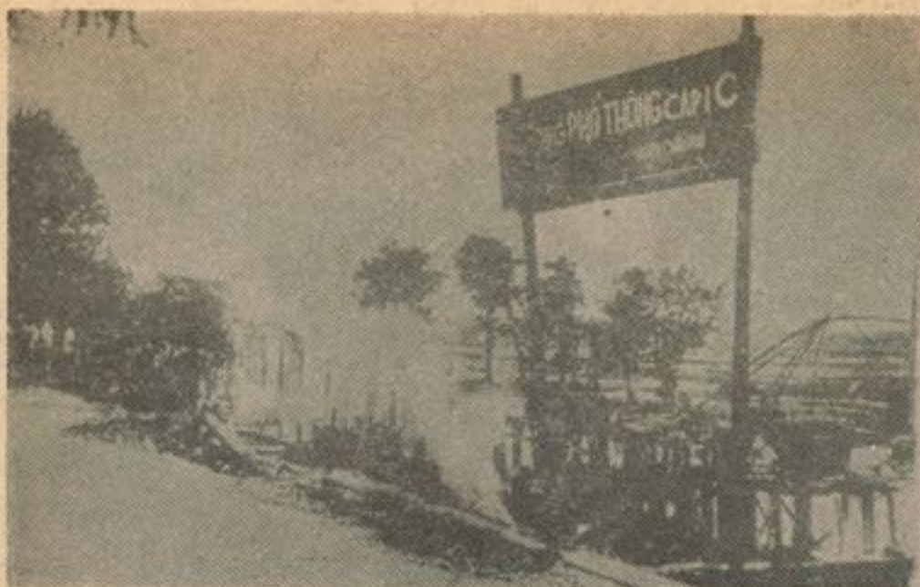
يك مکتب حریق شده در انگیانگ
