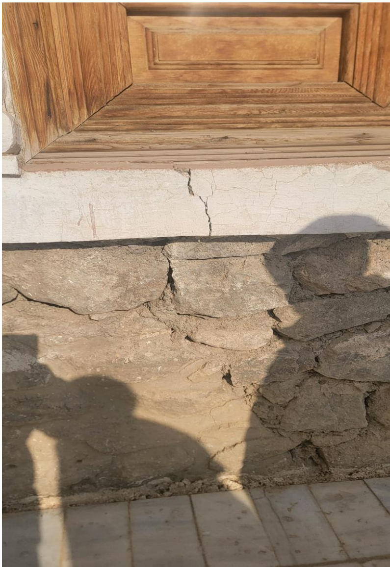
تصویری از ترک (درز) عمودی در ساختمان حرمسرا
