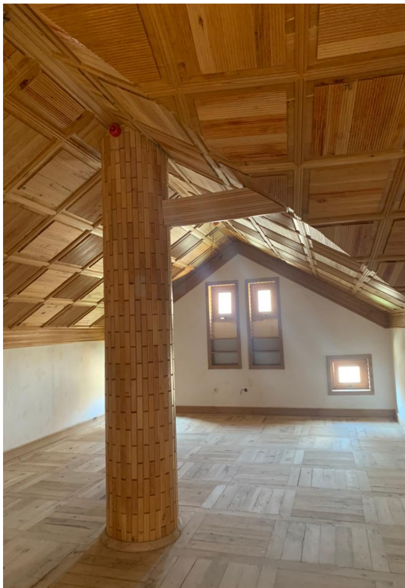
تصویری از ساختمان داخلی حمام و تشناب
