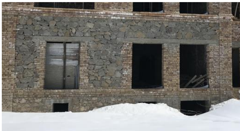
تصویری از قصر حرمسرا در جریان ساختمان
