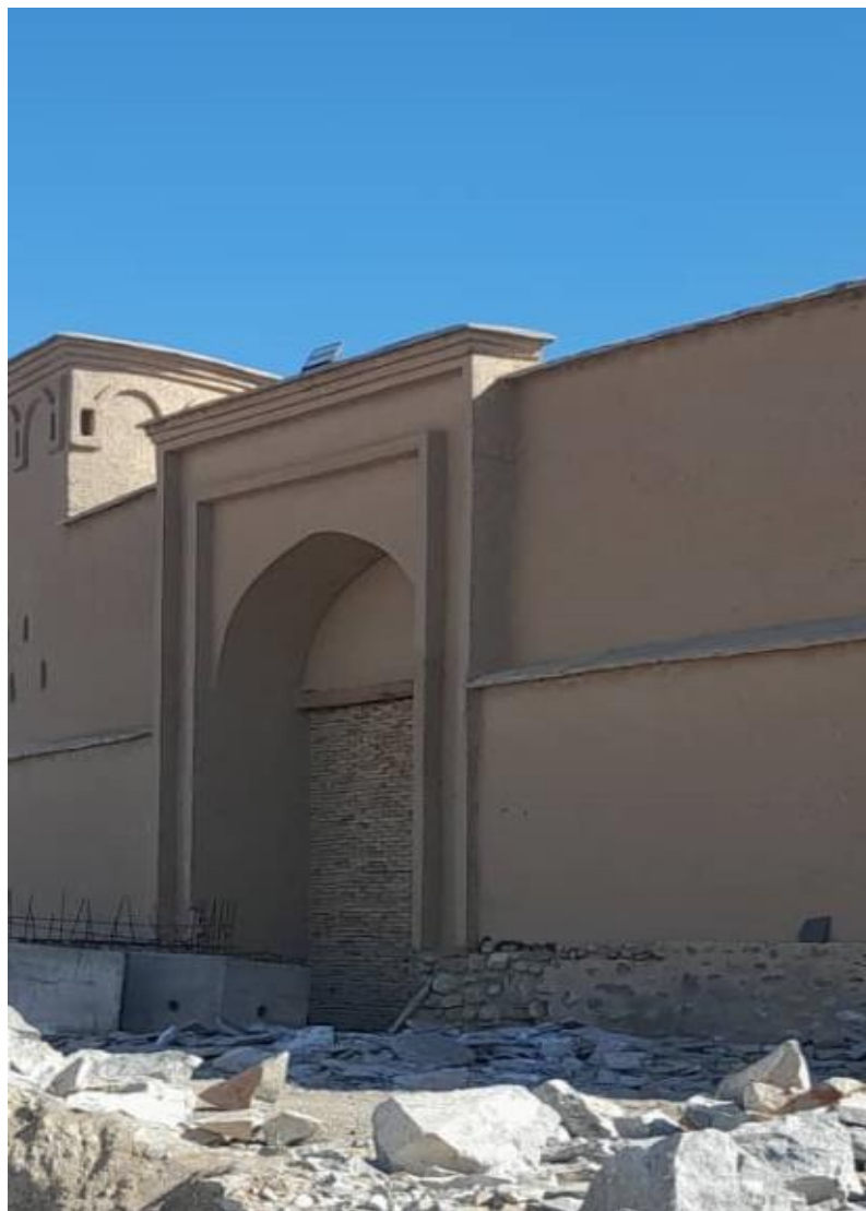
تصویری از قسمت دروازه عمومی غربی قلعه
