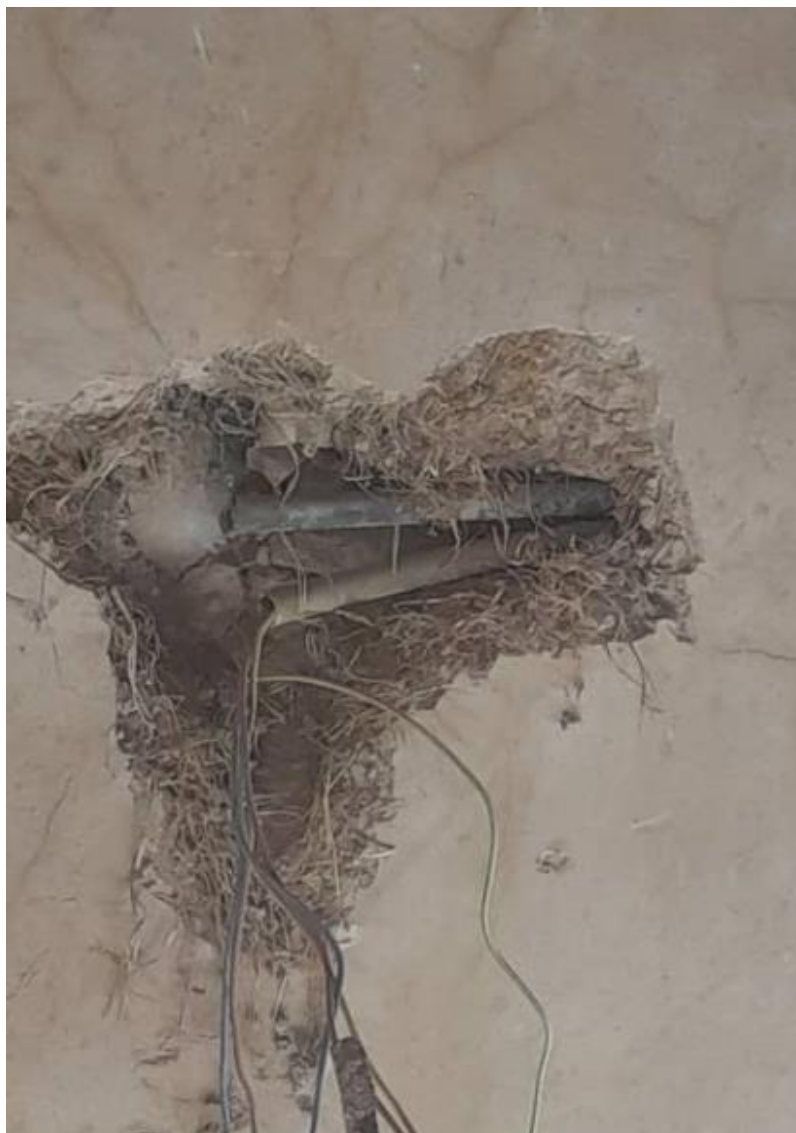
تصویر قسمتی داخلی یکی از تونل ها (بونکر ها)
