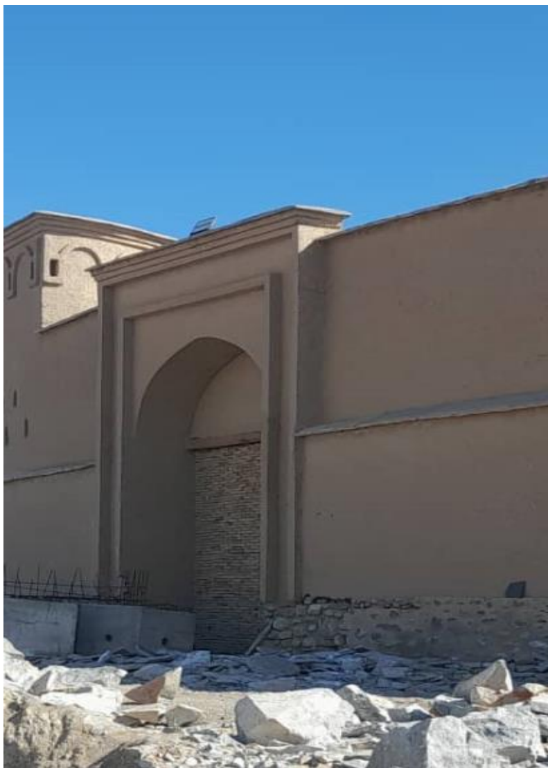
تصویری از قسمت دروازه عمومی غربی قلعه
