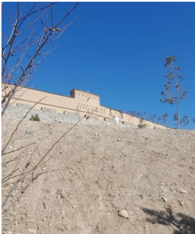
تصویری خارجی از دیوار احاطه قلعه بلند
