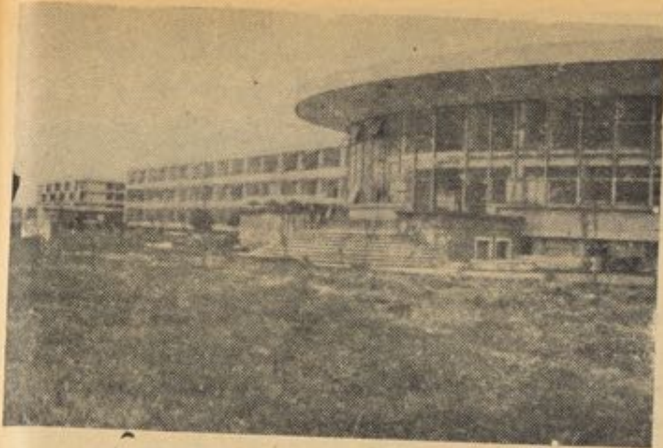
منظره از تعمیر تخنیک مزارشریف
