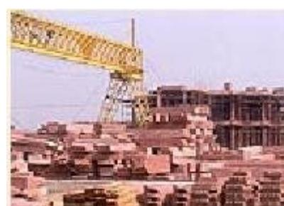
این هم دو تصویر دیگر که نوع و محدوده‌ی عملیات جرثقیل ها را نشان می دهد. دپو کردن بسیار ظریف و دقیق سنگ هایی که باید با نهایت احتیاط بر روی هم چیده شوند و در تدارکات پروژه و نه اجرای آن فعال اند. نیاز به مراقبت برای ممانعت از لب پریدگی هایی که در هر لغزش دست ممکن است قطعه ای دشوار عمل آمده را غیر قابل مصرف کند، به کارگیری جرثقیل در خارج از محیط معابد را ناگزیر کرده است.
